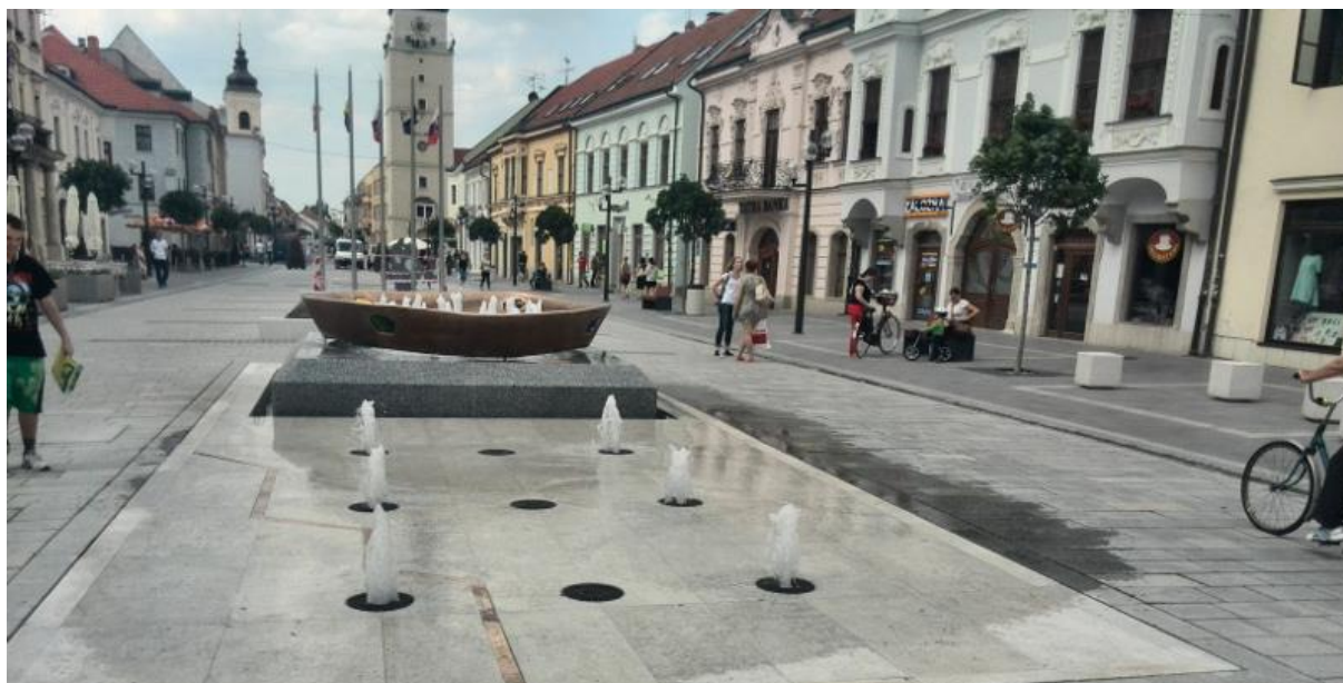
Názov stavby: Obnova verejných priestorov Hlavnej ulice v Trnave – Pešia zóna, lokalita Trnava
